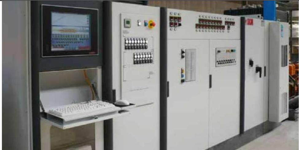
Il programma supervisor, infatti, è stato realizzato con lo scopo appunto di facilitare l'operatore nella gestione di un forno a rulli per la produzione di ceramica. La gestione è affidata a un PLC, per l'acquisizione dei dati sul "campo" e il relativo controllo, e ad un PC industriale come interfaccia uomo-macchina; tramite il PC è possibile controllare, analizzare e modificare ogni parte della macchina
